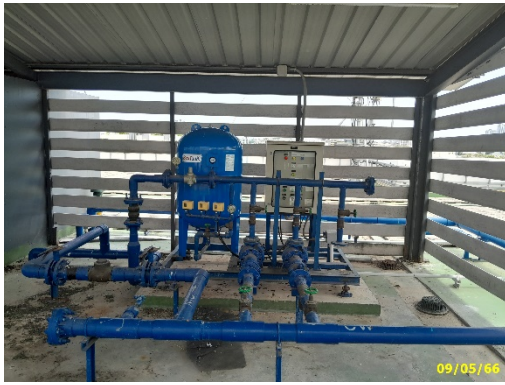
เครื่องสูบน้ำ และ Booster pump
